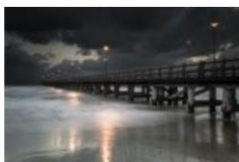
Forte dei Marmi Bridge
